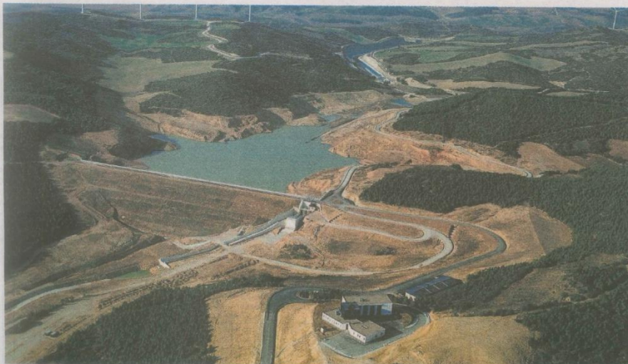
Balsa de Artajona y centro de control de la primera fase del Canal de Navarra. La balsa está en el tramo final de la 1ª fase.
